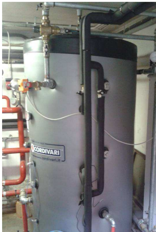
Fig. 7 - Accumulo per ACS con integrazione solare
