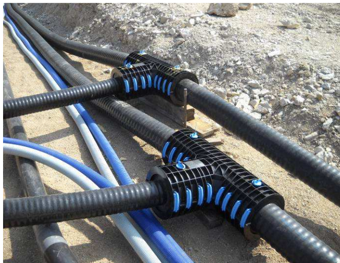
Fig. 9 - Particolare stacco per utenza
