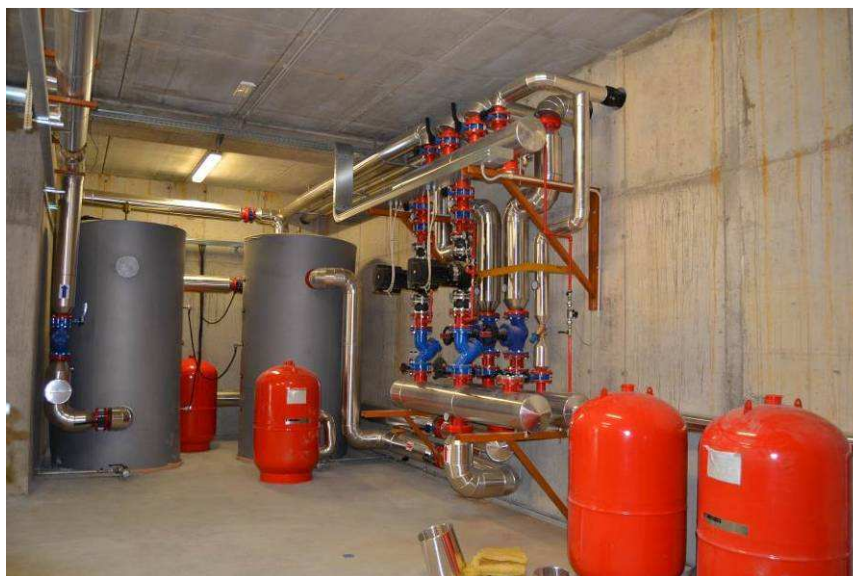
Fig. 3 - Accumuli termici e gruppo di distribuzione alle utenze
