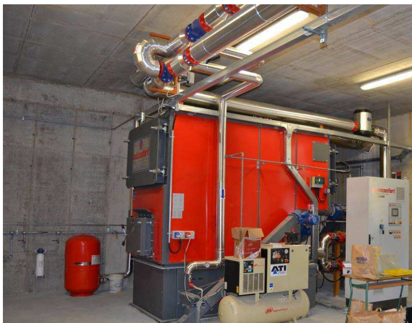
Fig. 2 - Caldaia a biomassa installata
