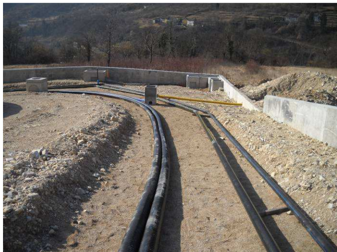
Fig. 8 - Dorsale principale rete di teleriscaldamento
